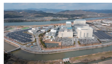
左侧为No1太阳能发电站， 右侧为No2太阳能发电站
