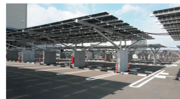
汽车棚型太阳能发电系统
